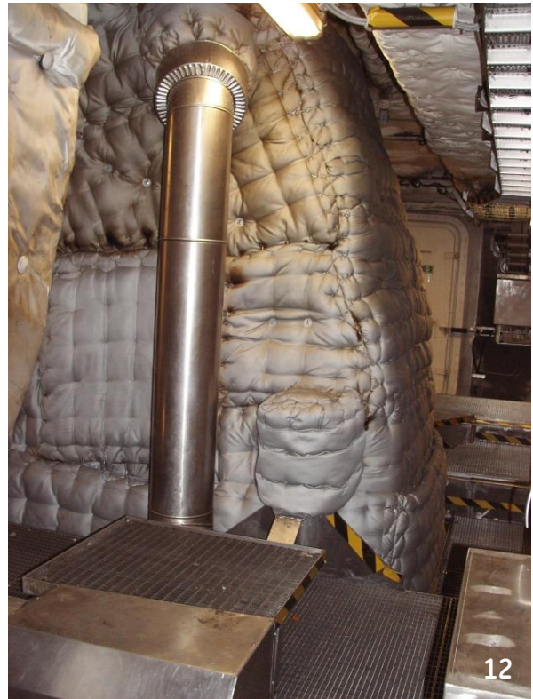
Isolatieleden rondom het uitlaat kanaal
